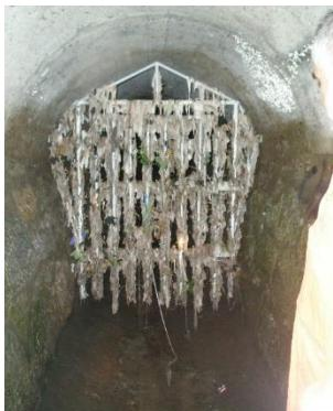
Teure Investitionen in Abwasserreinigungsanlagen werden so absurdum geführt. Darüber hinaus führen diese Stoffe auch zu Problemen in Regenüberlaufbecken (Verstopfung der Entleerungspumpen, Geruchsbelästigung, usw.).
